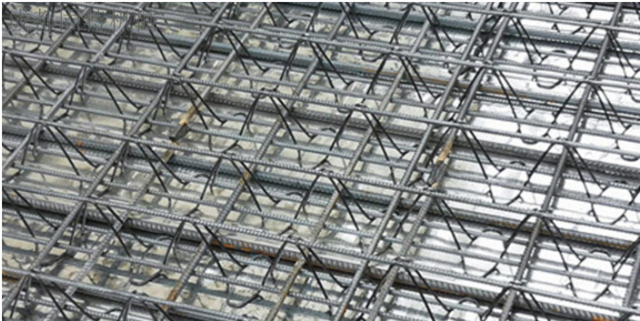
钢筋桁架混凝土楼板按双向板计算时与普通现浇混凝土设计理论等同，而其钢筋珩架受力模式更为合理，能提供更大的刚度，且双向刚度一致。4结束语综上所述，目前我们在建筑物建设的过程中，人们对于钢筋桁架楼承板的运用已经十分广泛，更是由于它的方便性和经济性，而且还具有传统楼板的防火、防腐、抗压等特性，da大的推动了施工技术的发展。但是由于，人们在进行施工设计是对于钢筋结构的掌控还不是很全面，并且在进行制造是多对钢筋和混凝土的比例也不是很好掌握。因此，我们在钢筋桁架楼承板技术的施工和设计时，还存在着许多的问题。不过这些问题对我们的社会经济发展没有什么太大的影响，所以我们还行要在以后的社会实践中对其进行探讨。
